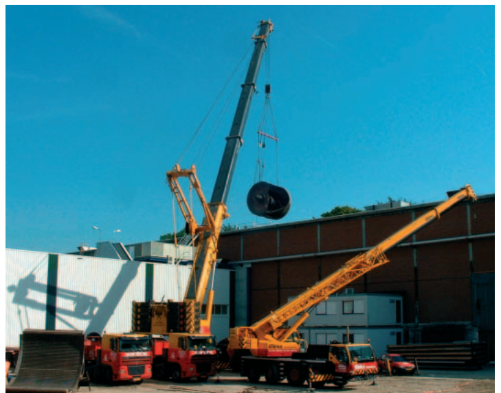
Ausbau durch das Dach der Fabrik.
