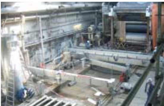
Während des Wiederaufbaus. Mehr als 300 Techniker arbeiteten an dem Umbau 24 Stunden pro Tag.
